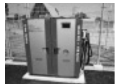
リチウムイオン蓄電池
